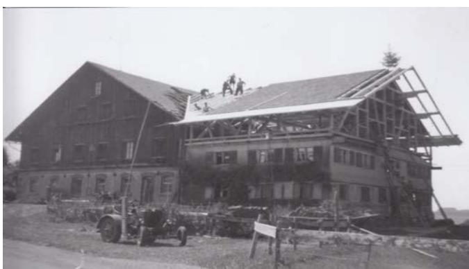
Aufstockung des Wohngebäudes 1952
